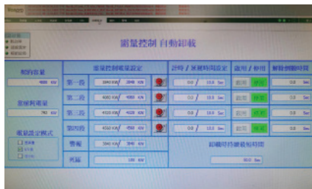
中控室 用電需量即時監視畫面
