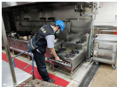
瓦斯儀器洩漏偵測
