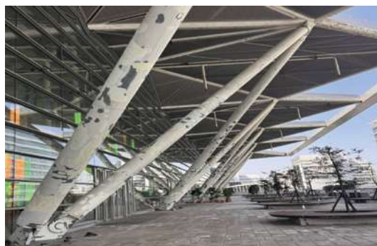
室外鋼柱施工前
