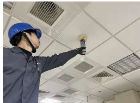
瓦斯儀器洩漏偵測
