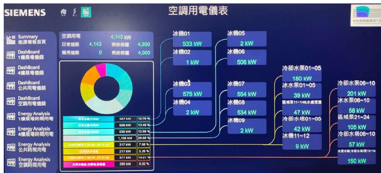
展場空調系統增設冰水泵及冷卻水泵變頻控制
