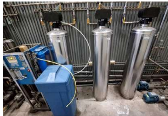
採 RO 逆滲透中央飲水系統
