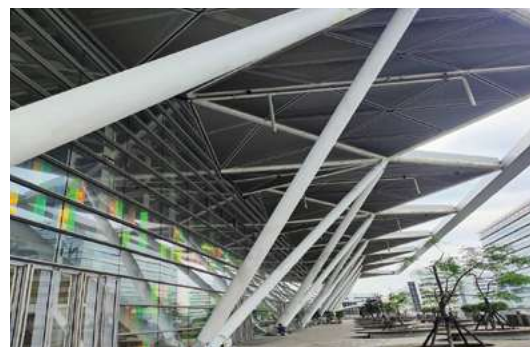
室外鋼柱施工完成
