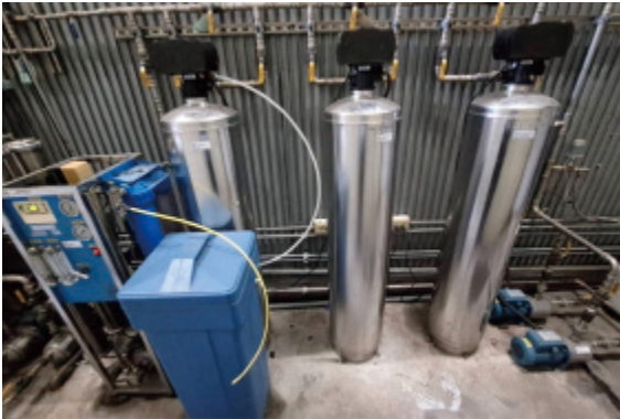
採 RO 逆滲透中央飲水系統
