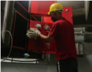
商店街油脂截油槽、排油煙靜電機清洗及設備維護
