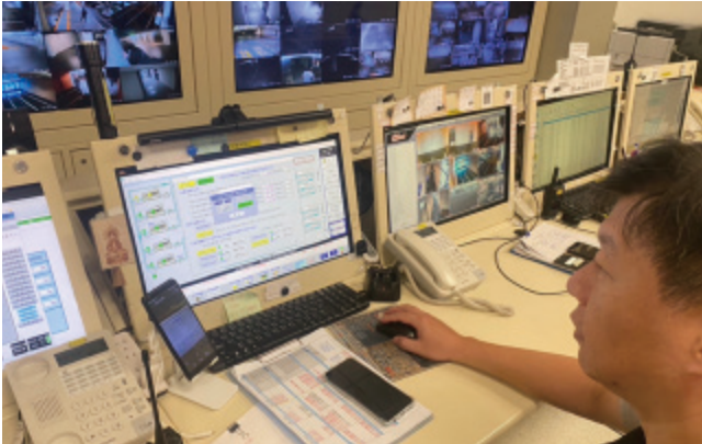
南港 2 館中控室遠端操作冰機設備改善用電效率
