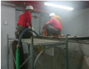
商店街油脂截油槽、排油煙靜電機清洗及設備維護
